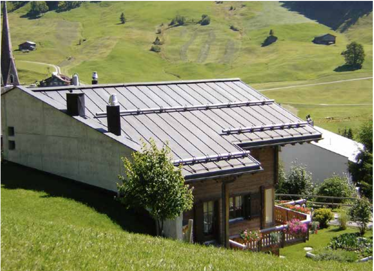
Abbildung 1: Verstärkte Rückwand zum Schutz vor Lawineneinwirkung in St. Antönien GR Bild: M. Bründl, SLF
